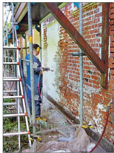
Am Mauerwerk der Kirche wurden die Zementfugen entfernt. Neue Fugen mit Kalkmörtel sollen die Feuchtigkeit aus dem Innenraum fernhalten. Foto: Hehnen
