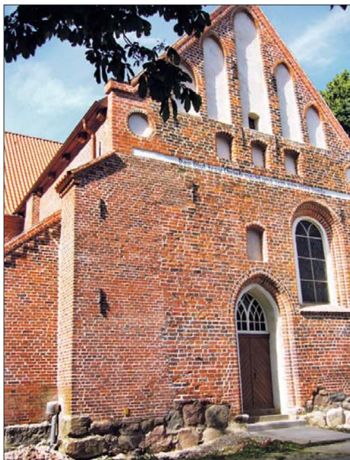
Am Mauerwerk der Kirche wurden die Zementfugen entfernt. Neue Fugen mit Kalkmörtel sollen die Feuchtigkeit aus dem Innenraum fernhalten. Foto: Hehnen
