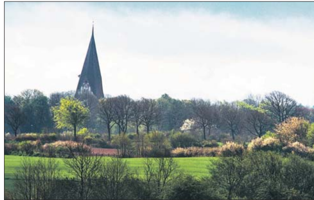
Die ehrwürdige St.-Jürgen-Kirche in Gettorf braucht eine Grundsanierung. Sie wurde von Feuchtigkeit befreit und bekam einen neuen Dachstuhl. Foto: Heinz Teufel
