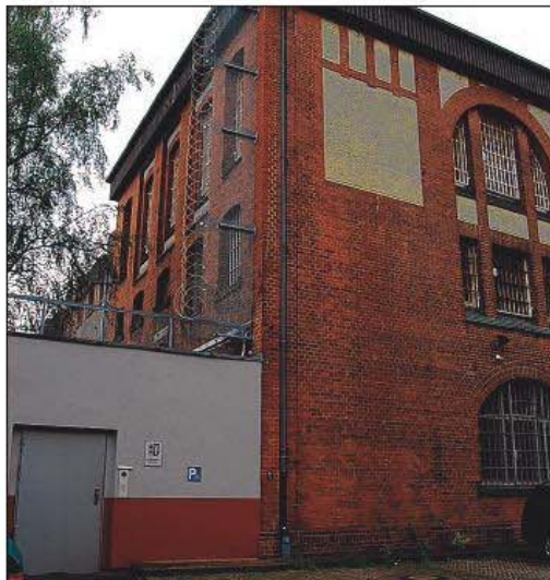
Außenansicht: Die Abschiebungshafteinrichtung des Landes Schleswig-Holstein in Rendsburg.
